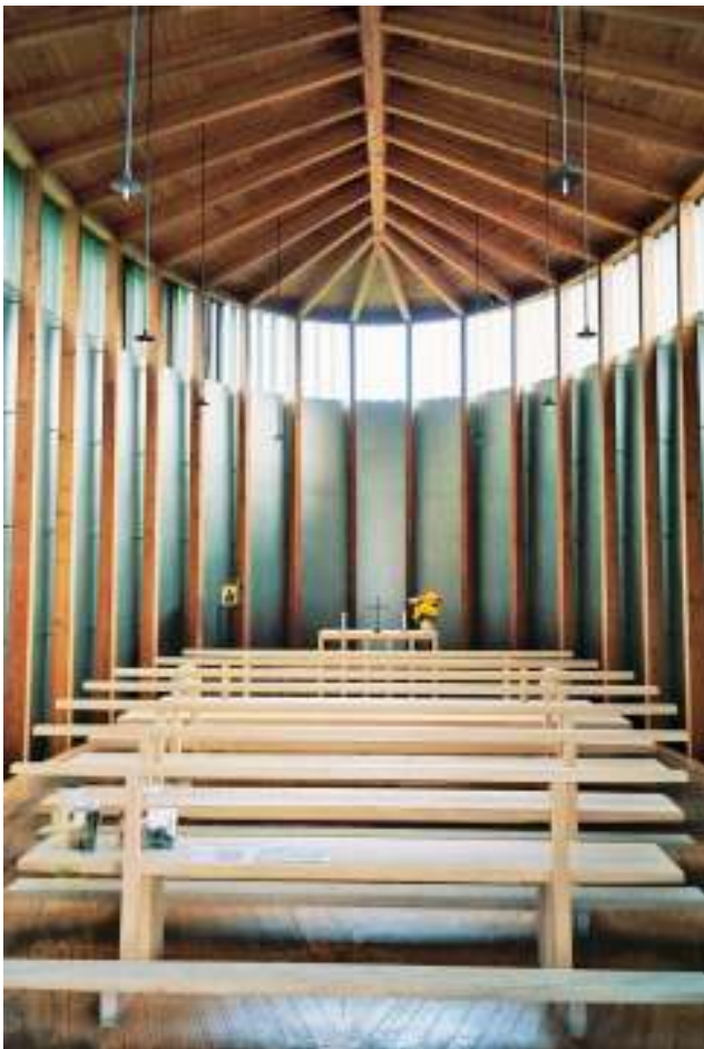
葉脈のような天井と高窓、天井を支える細身の柱
