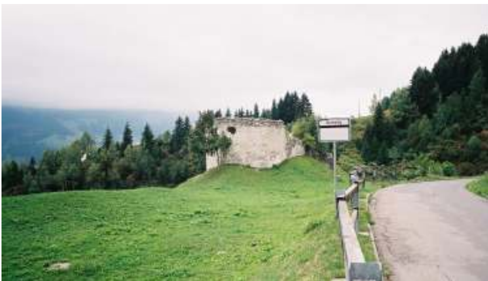
雪崩で崩壊した元の教会
