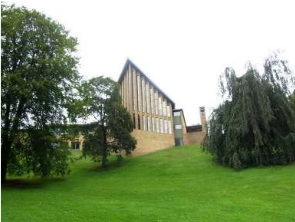
緑の傾斜地より見上げる
