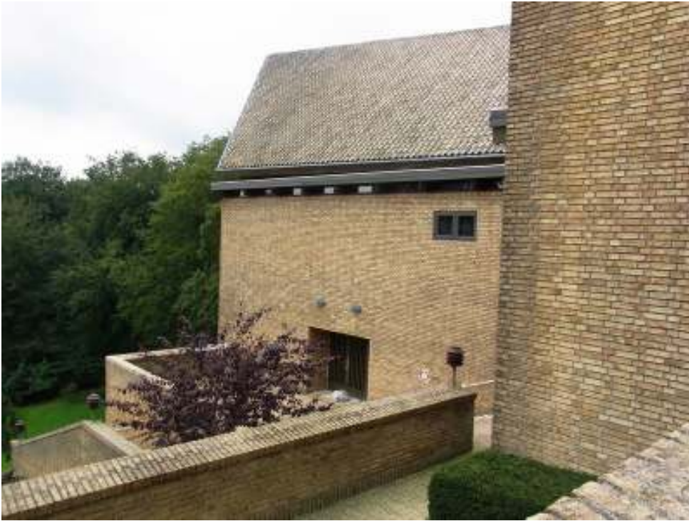
傾斜地に降りる外通路
