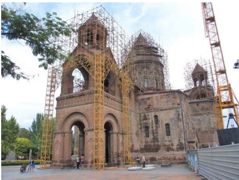
工事中の聖堂
